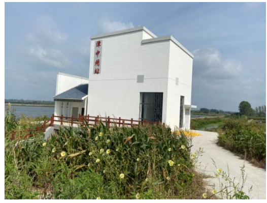
盐都区潭中闸站 (2020.09.07)
