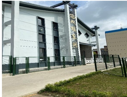
海安市双楼东闸（2021.09.17）
