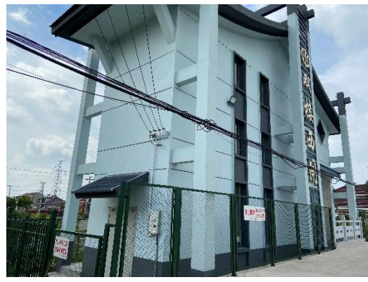
海安市双楼西闸（2021.09.17）
