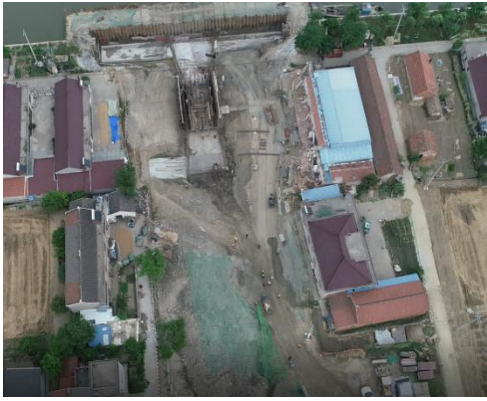
海安市双楼西闸（2020.3.10）
