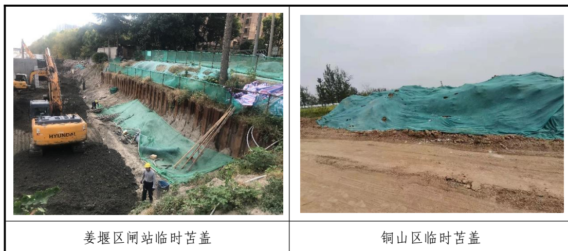
图 4.3-1 临时措施实施情况
