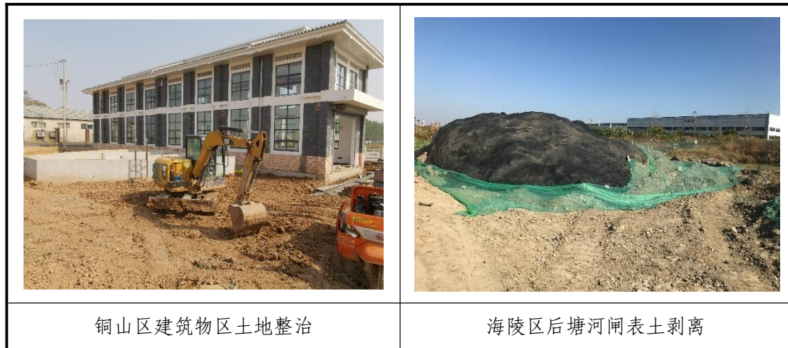
图 4.1-1 工程措施实施情况
