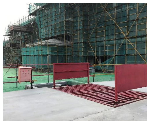
洗车平台及配套沉沙池（施工期间）
